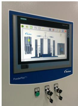
Die Netzwerkschnittstelle ermöglicht außerdem den Datenaustausch, vollständige Produktions-, Verbrauchs- und Materialdatenerfassung ist möglich. Als Teil eines komplett integrierten Systems steuert die PowderPilot HD Steuerung auch die Nordson ColorMax Kabine, Nachfilter, Hubwerke und Encore HD Pistolen.
